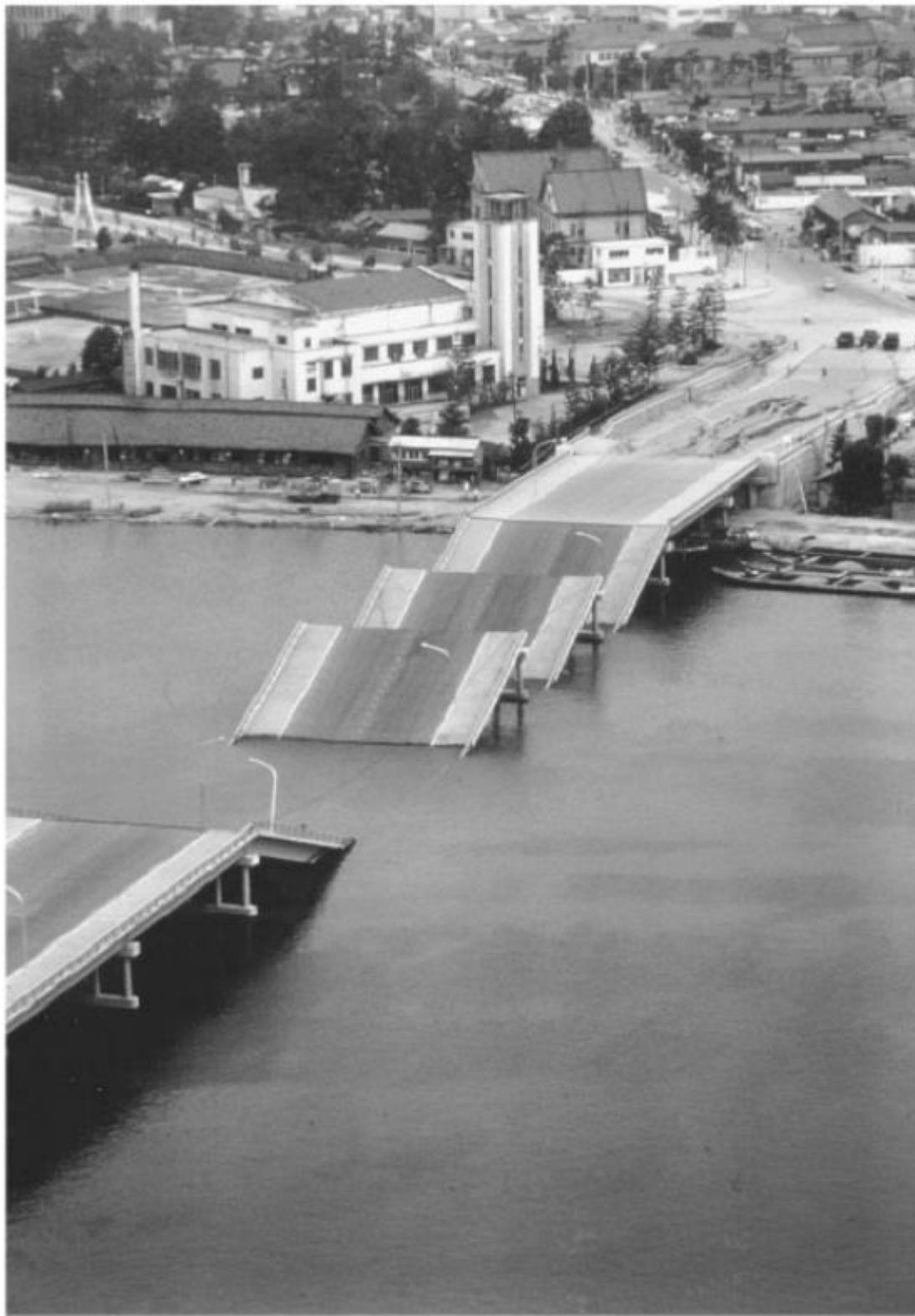
Рисунок 1.4 – Фотографии сброшенных пролётных строений моста Showa при землетрясении Niigata в 1964 году
