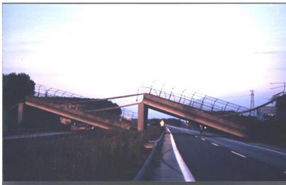
Рисунок 1.2 – Фотография сброшенных пролётных строений путепровода Agiye (Турция)
