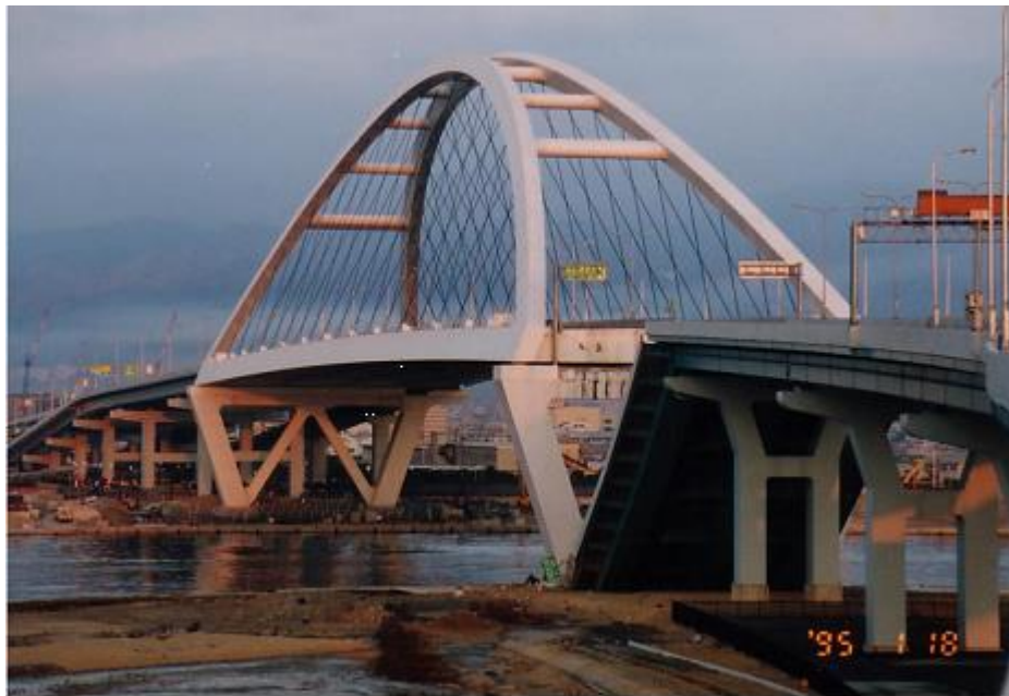
Рисунок 1.1 – Фотография сброшенных береговых пролётных строений моста Nishinomiya Bridge во время землетрясения 1995 Kobe
